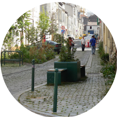
Exemple d'aménagement d'une rue jardin , chaussée poreuse, rue Kleber à Bordeaux
