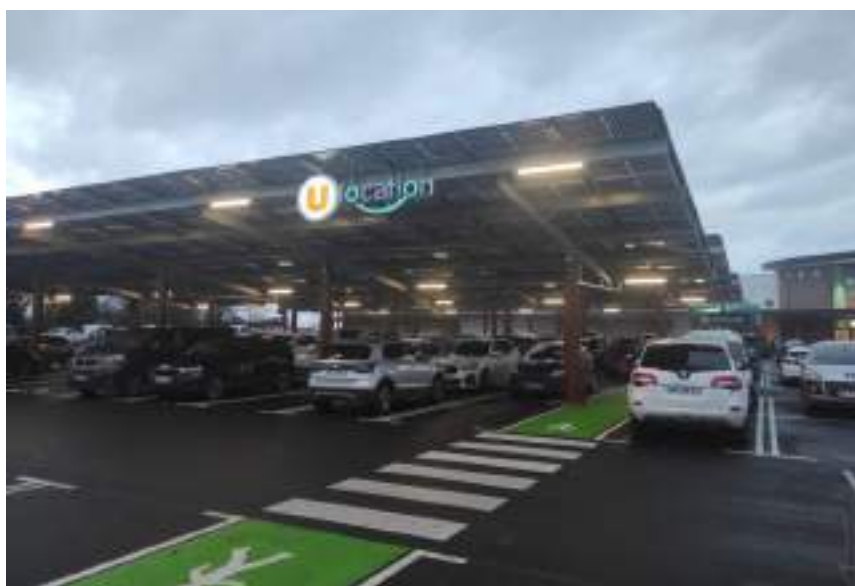
Parking du Super U de Savignieux, Loire Forez Agglomération, epures
