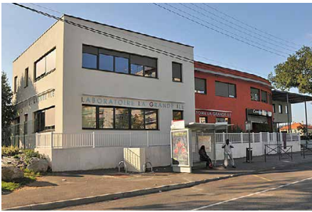
Centre de santé Jean Goulard à Vaulx-en-Velin (2009) © M.P. Ruch / Agence d'Urbanisme Lyon 2013
