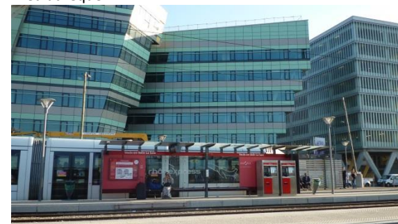
Le pôle multimodal de la Soie : Les deux lignes de tramways T3 et Rhônexpress utilisent la même emprise depuis la Part-Dieu jusqu'à Meyzieu ZI.
