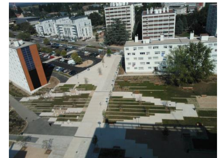
Réaménagement des espaces publics Semailles Ouest à Rillieux-la-Pape
