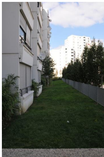
Traitement des pieds d'immeuble
