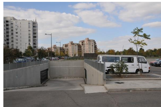
Accès au garage souterrain
