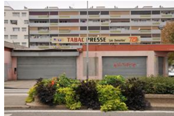
L'ancienne galette commerciale démolie en 2011, avenue des Nations à Rillieux-la-Pape.
