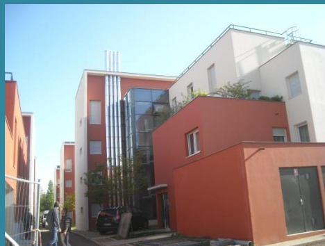
La reconstruction du foyer Kruger
