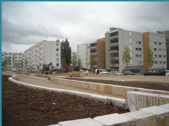
L'aménagement de l'espace public central de l'îlot de la Poudrette
