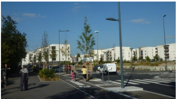
Réaménagement de l’avenue Gabriel Péri : la chaussée est rétrécie pour libérer de l’espace et réaliser des trottoirs plus larges avec des plantations d’arbres, une piste cyclable (2011). © Nicole Ponton
