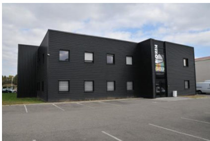
PME implantées à la Grappinière à Vaulx-en-Velin
