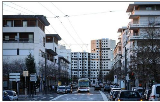
AVANT : les immeubles du Pré de l'Herpe vus de la rue Emile Zola
