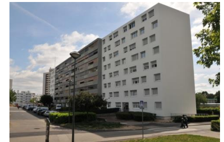
Semailles : démolition partielle, 60 réhabilitation des logements locatifs sociaux
