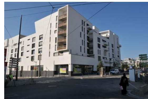
La Duchère Ilot 14 - Opac du Rhône : programme Nelson Mandela de 79 logements (54 PLUS CD et 24 PLS) – Densité : 220 logements à l'hectare (Livraison en 2011)
