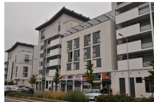
Commerces installés en pied d'immeuble à Sermenaz (Rillieux-la-Pape) : boulangerie, Pizzeria snack, hammam, assurance...
