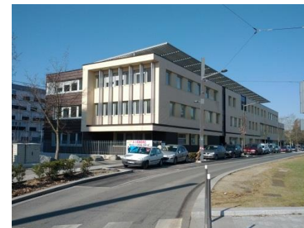
Le Corallin : Immeuble d'activités
