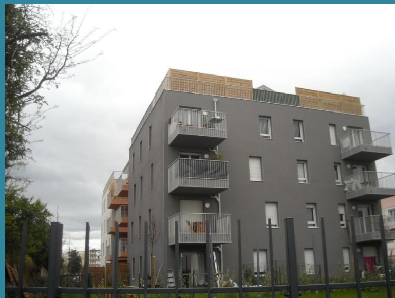
Programme de 29 logements neufs sur l'îlot de la Poudrette
