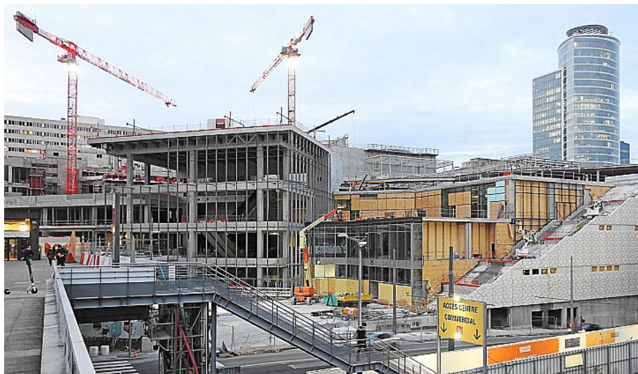
Chantier du centre commercial Part-Dieu début mars 2020 © urbalyon
