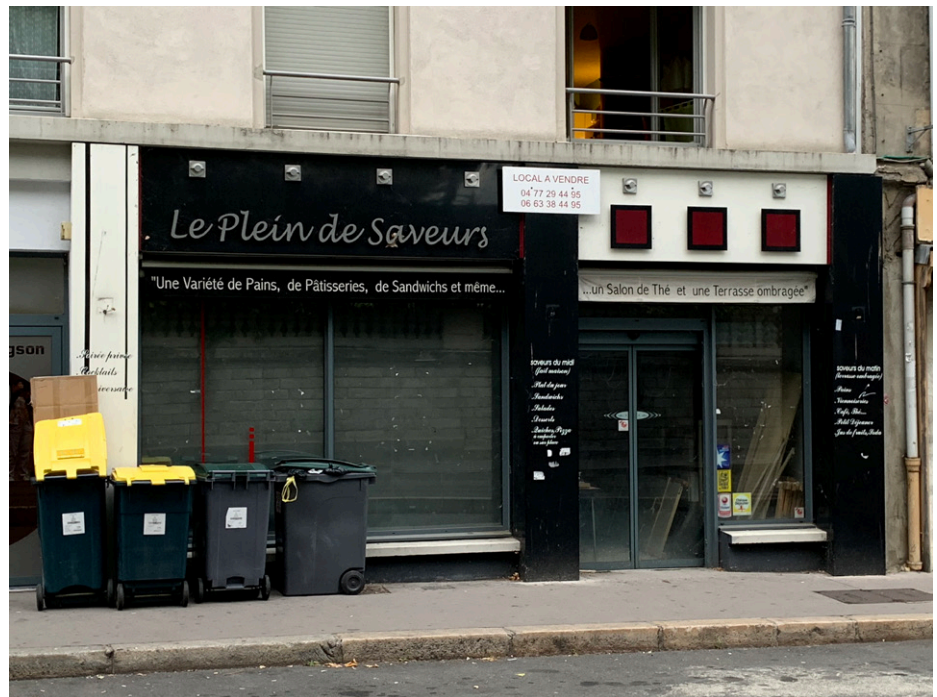
Croissance de la vacance commerciale © Epures
