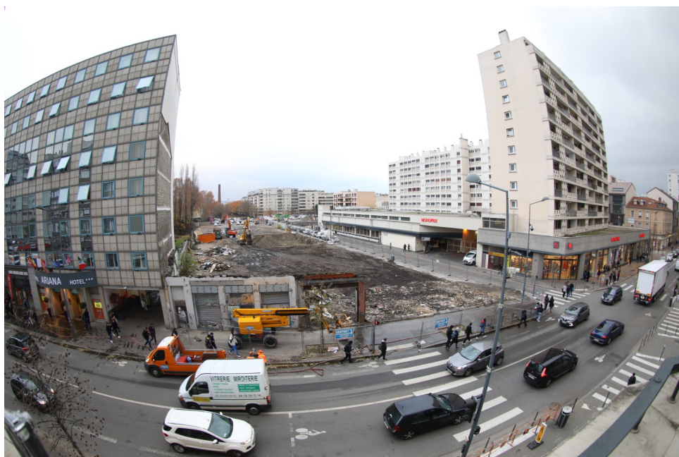
Chantier du prolongement de l'avenue Henri BARBUSSE © Franck CHARLIN Agence d'urbanisme de Lyon
