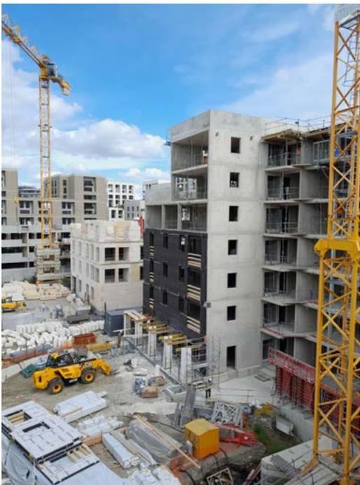
La pose des façades à ossature bois, qui arrivent préfabriquées sur site avec leur pare-pluie extérieur et leur pare-vapeur intérieur, est très rapide. Les FOB du bâtiment F auront été posés en 3 semaines. La pose des menuiseries dans la continuité permet d'assurer un hors d'eau rapide.
