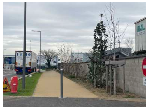
ZAE Portes du Dauphiné - requalification en cours des espaces publics ©Urbalyon
