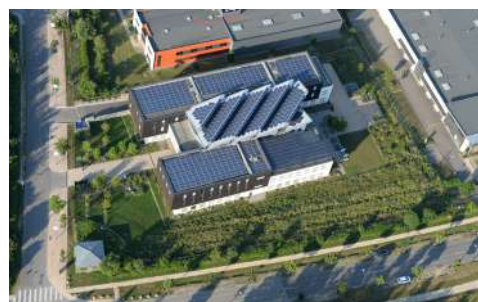
Toiture solaire - bâtiment d'activité - Parc technologique de la Porte des Alpes ©Urbalyon
