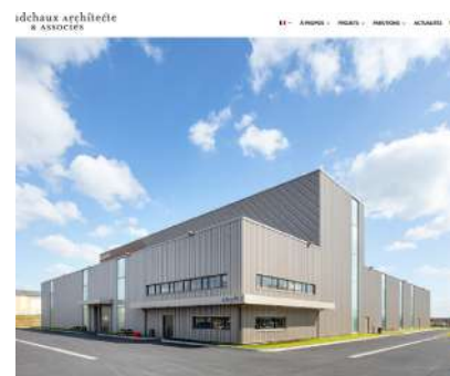
Bâtiment Axon câbles, à Montmirail ©Goudchaux Architecte & associés
