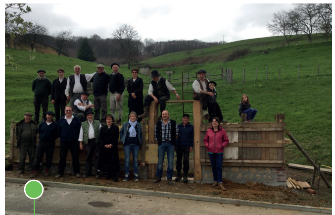
Construction du muret - source : Brion
