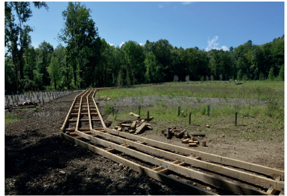
La passerelle dans la zone nature, lors de sa construction en mai 2022
