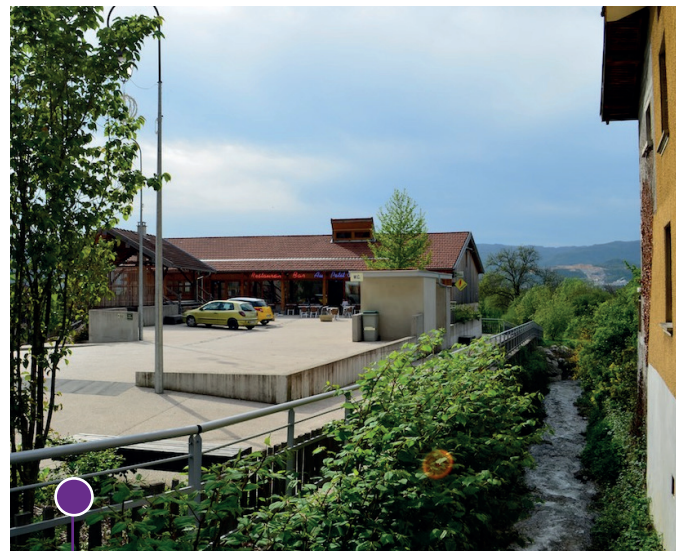
La place centrale le long de la rivière et le bassin d'orage Source : site internet de la commune de La Rivière
