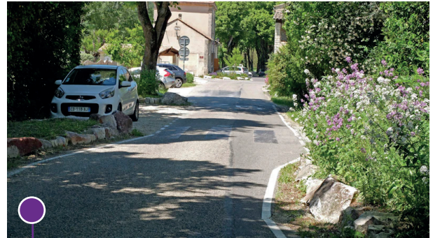
Axe routier réaménagé à Montjoux La Paillette Source : Pénélope Haas, maître d'œuvre du projet, 2021
