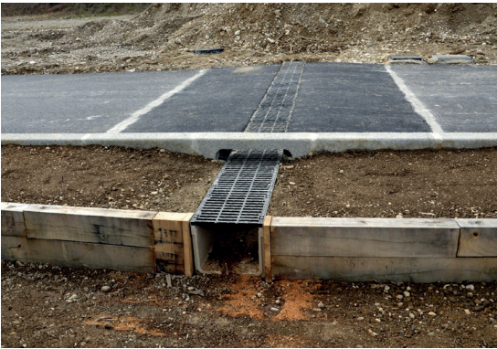
Passage à faune installé sur l'ensemble du site pour protéger le passage des petits habitants de l'éco hameau
