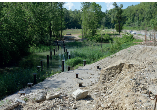
Pieux de soutien de la passerelle permettant de traverser la zone humide du site
