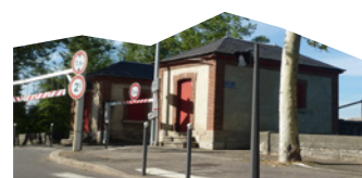
Givors Réouverture et création de nouvelles barrières d'octroi (BARO)
