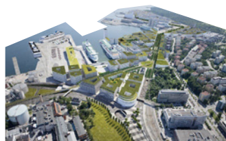
Vallée du Gier : Hub industrialo-fluvial et sa marina
